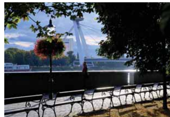
Atraktívny priestor je znehodnotený vizuálnou bariérou protipovodňového múrika.
